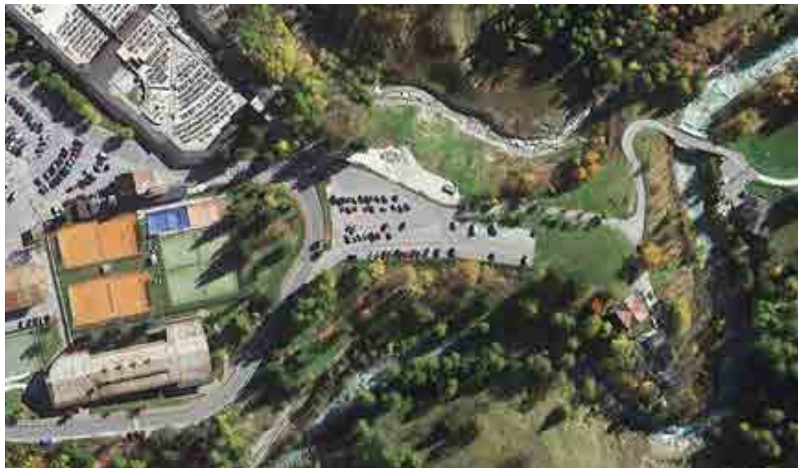
Sopra: la proposta di partenariato pubblico/privato avanzata da Pool Engineering e Quick no problem parking del nuovo parcheggio in località ex Polveriera, con partenza di un nuovo impianto verso Socrepes. Sotto: la situazione attuale della zona interessata all'intervento
