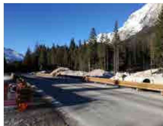
I lavori sulla SS51 Alemagna in località Dogana Vecchia
