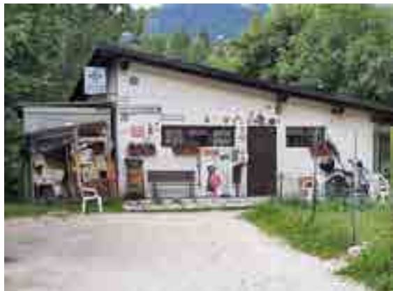
La sede dell'ambulatorio veterinario di Cortina dal 31 luglio non sarà più disponibile: verrà demolita per lasciar posto alla cabinovia Apollonio/Socrepes
