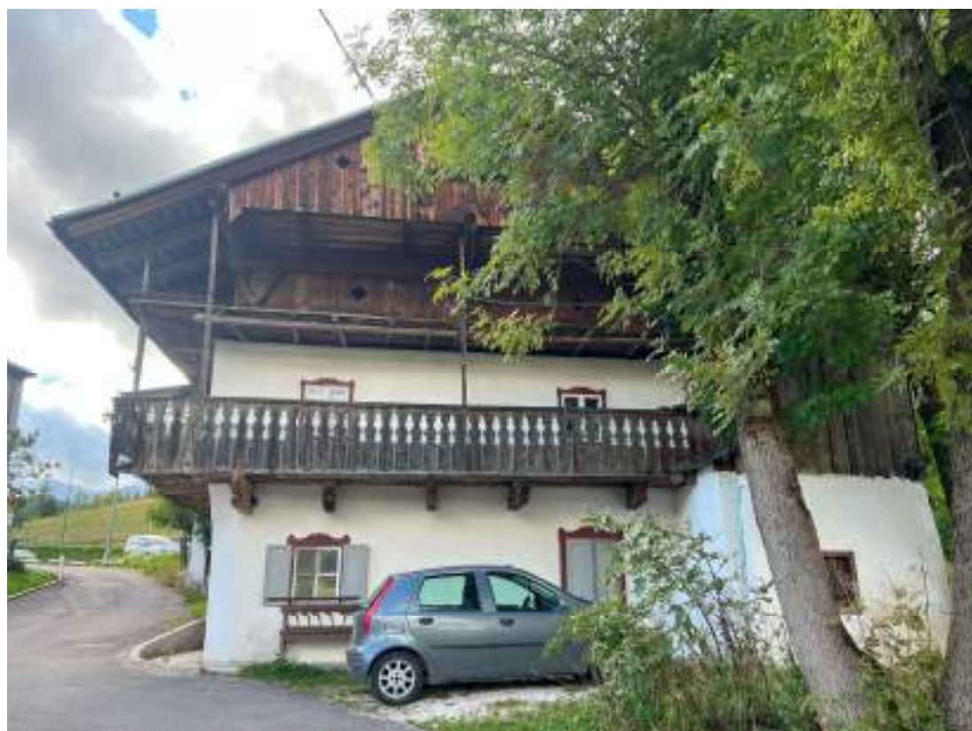
Vista porzione di fabbricato da est
