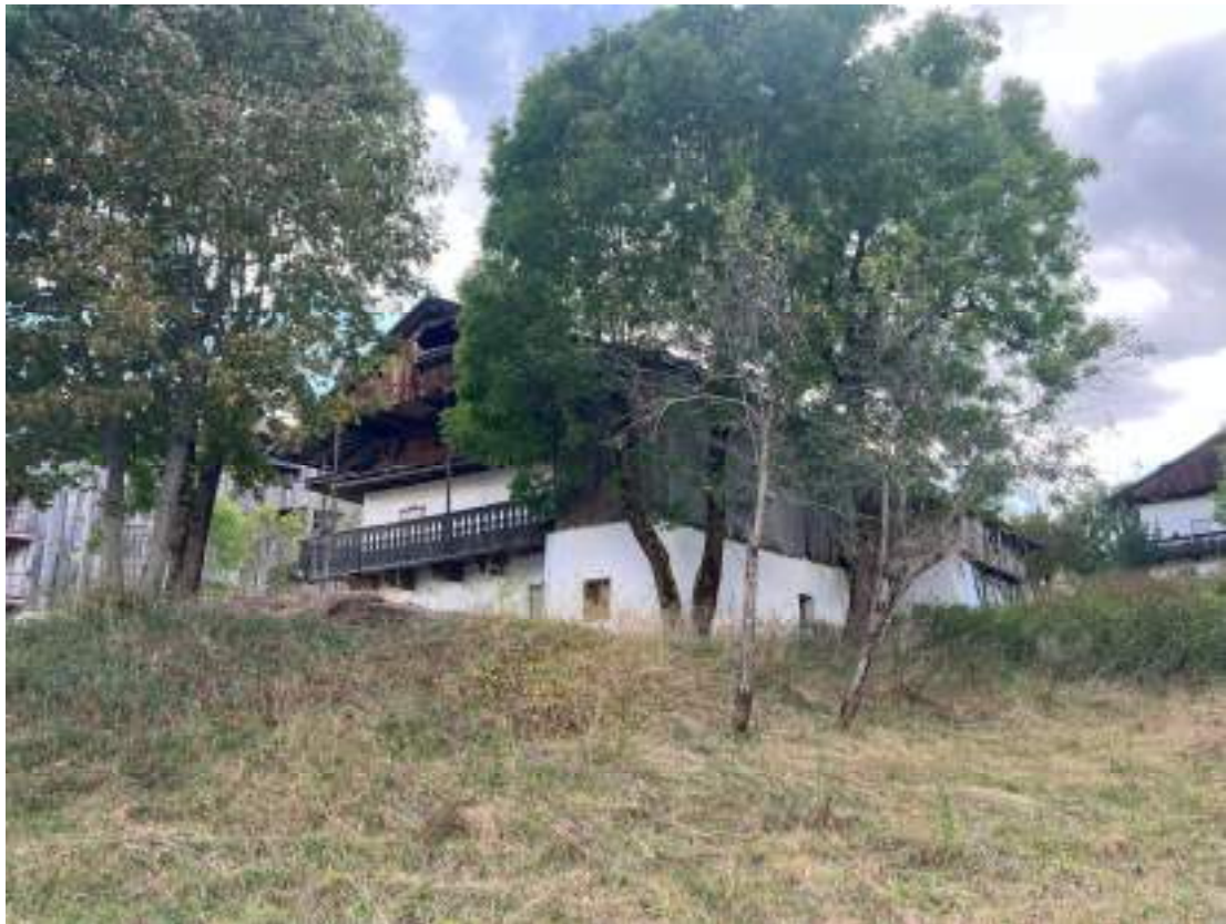
Vista fabbricato da nord-est
