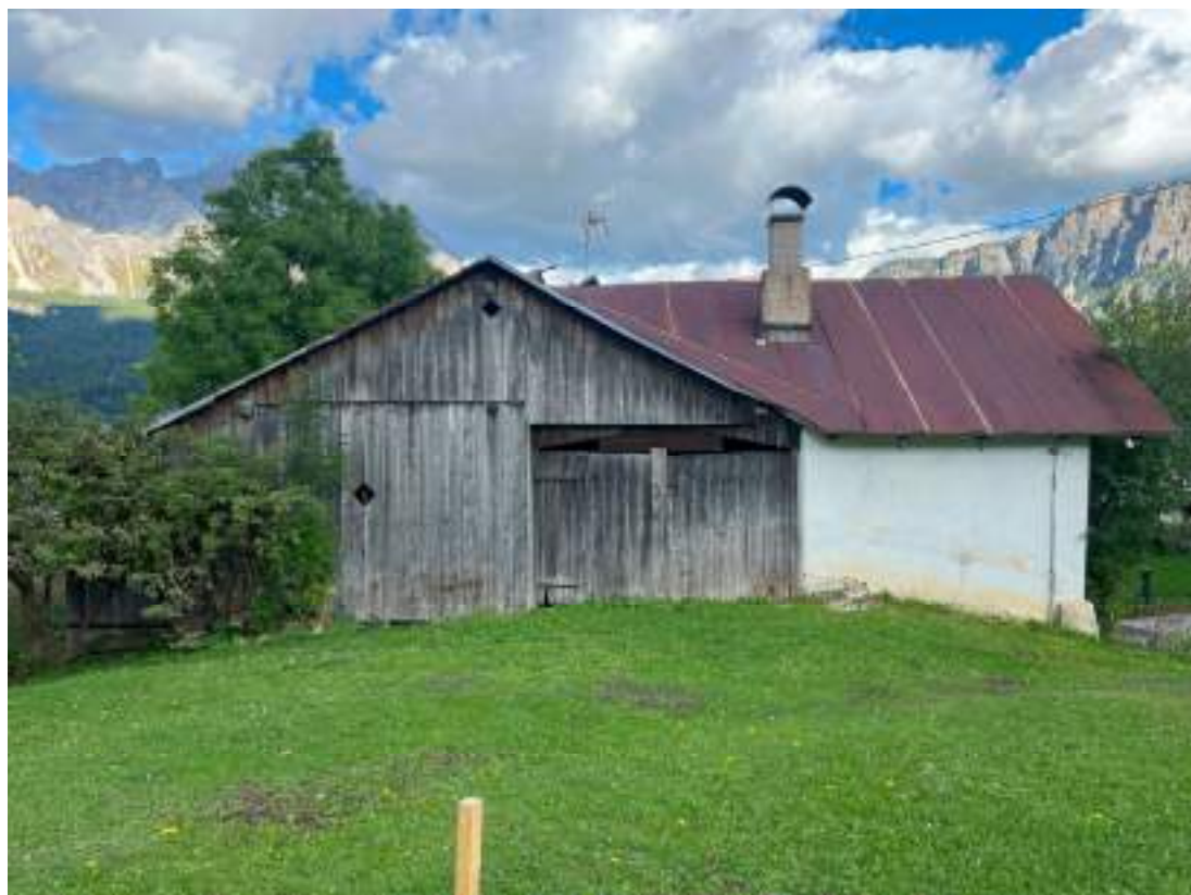
Vista fabbricato da ovest
