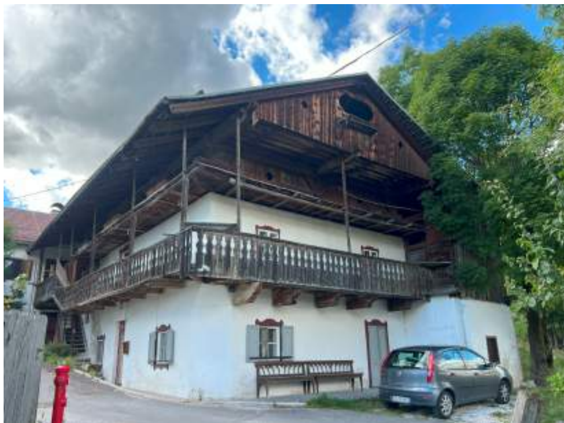
Vista porzione di fabbricato da sud-est
