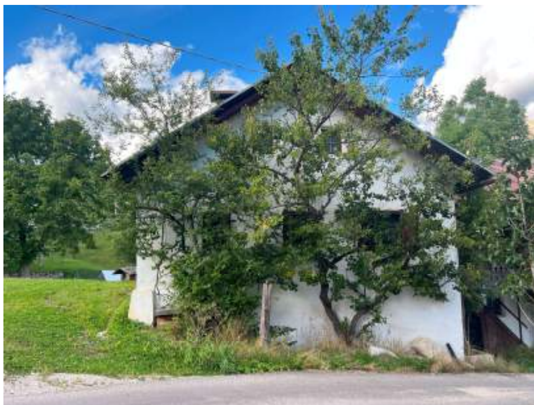
Vista porzione di fabbricato da sud
