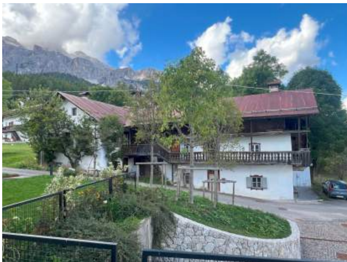
Vista fabbricato da sud
