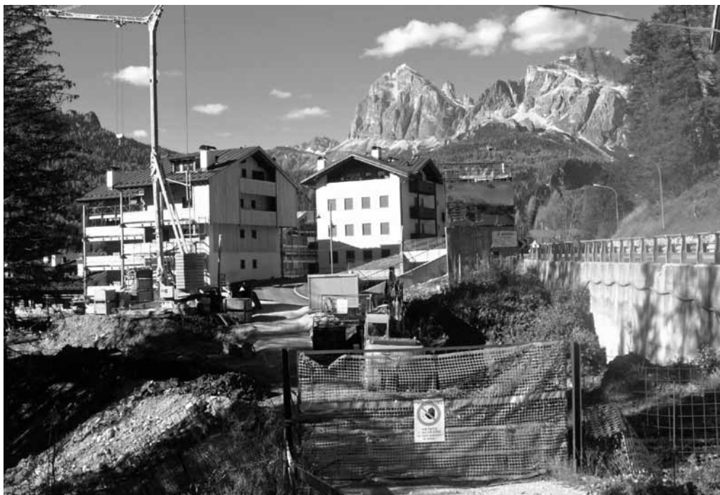
Il cantiere ad Acquabona, nella zona dell'ex Ancillotto
